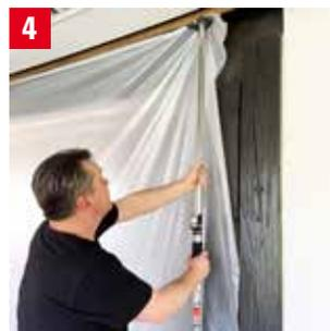
**4** Sobald die Deckenstütze auf der Folie senkrecht zwischen Decke und Boden steht, drehen Sie den Haltegriff im Uhrzeigersinn, um die Stütze fest zu fixieren.
