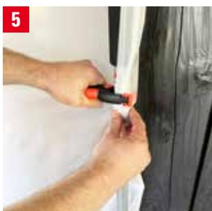
**5** Abschließend ist die überstehende Folie noch an den Deckenstützen zu befestigen. Dafür verwenden Sie Klebeband oder, wie hier im Bild gezeigt, schnell fixierbare Federzwingen.
