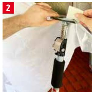
**2** Fixieren Sie die Folie mit Hilfe eines Klebebandes an der oberen Abstützfläche der Decken- und Montagestütze.
