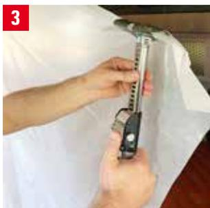
**3** Nun betätigen Sie die Lösetaste und ziehen die Teleskopstange soweit heraus bis sich Abstützfläche und Decke berühren. Danach ziehen Sie den unteren Teil der Folie unter die Abstützfläche der Deckenstütze am Boden.
